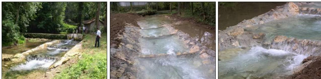
Par exemple, pour l'étang S8A, l'aménagement du seuil existant pourrait nécessiter l'installation de 4 petits seuils en enrochement avec échancrure de manière à assurer le franchissement (voir schéma de principe ci-dessous) :
